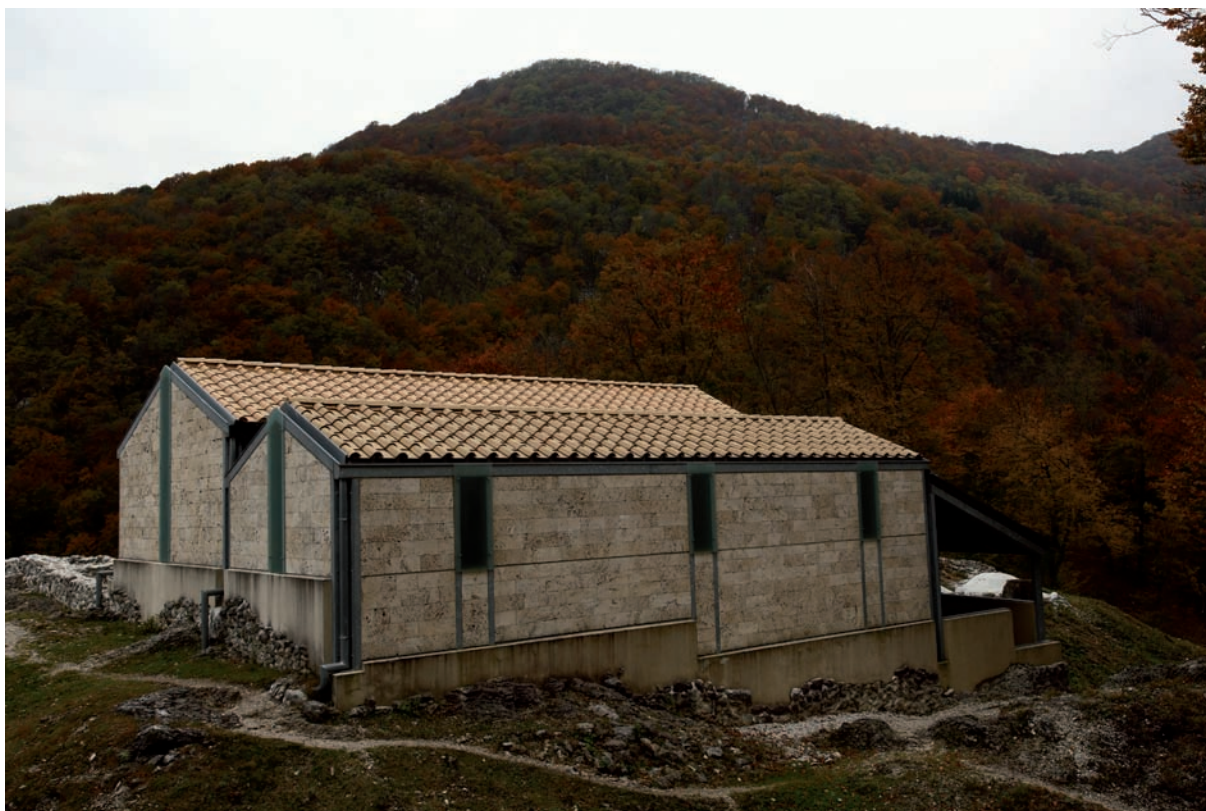
Sl. 1.13: Tonovcov grad. Pogled z vzhoda na zaščitni zgradbi nad severno in osrednjo cerkvijo.
