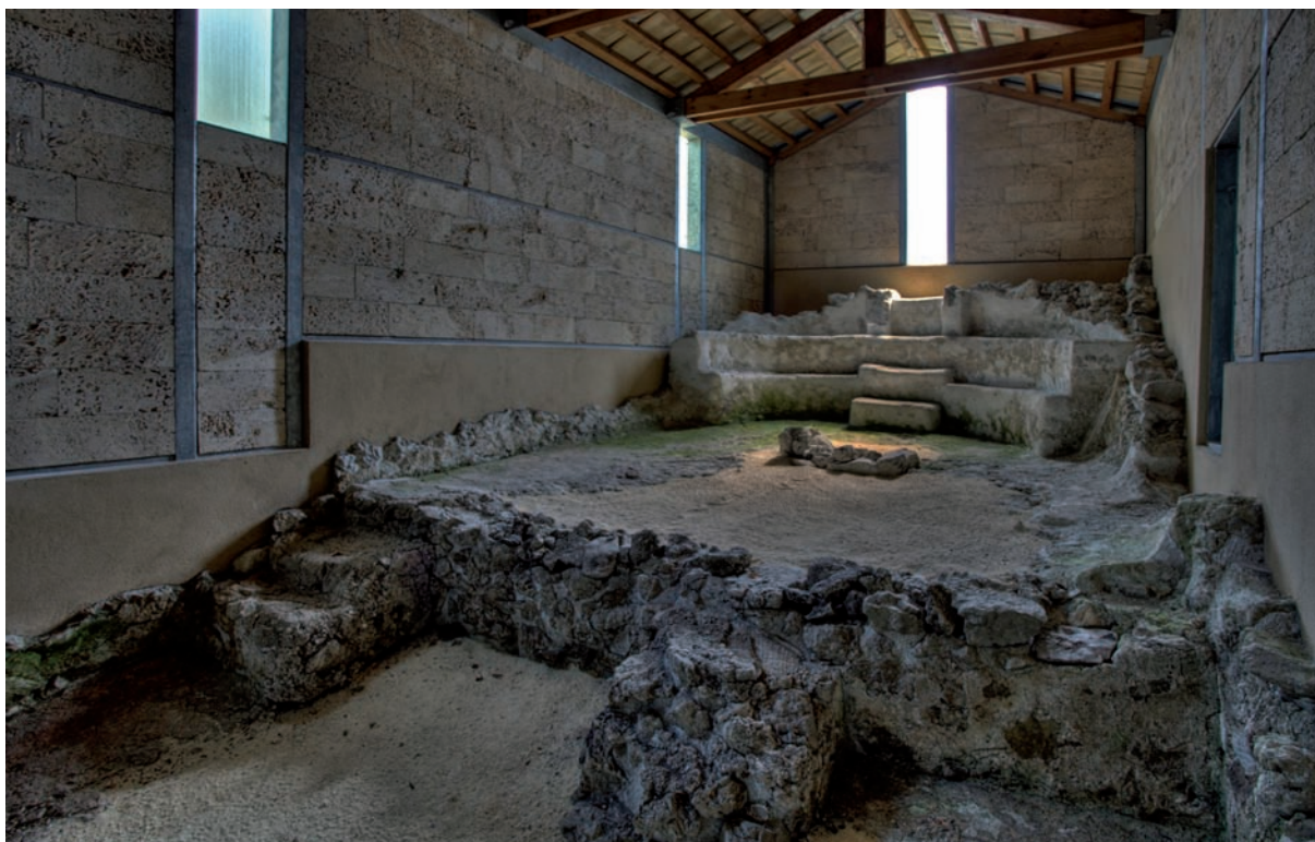
Sl. 1.14: Tonovcov grad. Odlično ohranjena in z moderno zaščitno zgradbo zavarovana notranjost severne cerkve.
