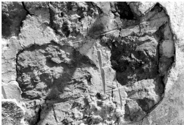
Sl. 4.15: Mali grad, kapela, podrobnost zidave *zidu 3* iz delno obdelanih peščenjakovih lomljencev v tehniki plastene zidave s črtnim fugiranjem (dokumentacija ZVKDS, OE Kranj, fotografija N. Leben).
