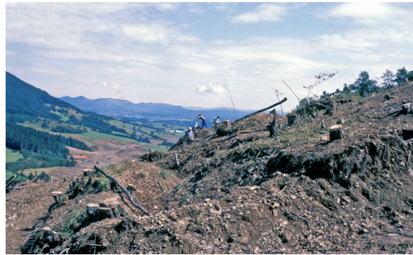
Sl. 14: Goli vrh. Območje hriba pred izkopavanji. Viden vojaški jarek 2. Pogled proti severovzhodu. V ozadju vznožje Nanosa in severni del Pivške kotline. Foto: V. Schein.
