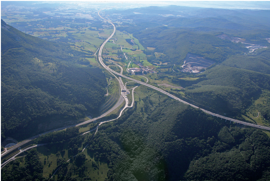
Sl. 9: Avtocestno križišče na prelazu Razdrto. Pobočje Nanosa na levi in Goli vrh na desni. Pogled proti vzhodu v Pivško kotlino. Foto: F. Novak.
