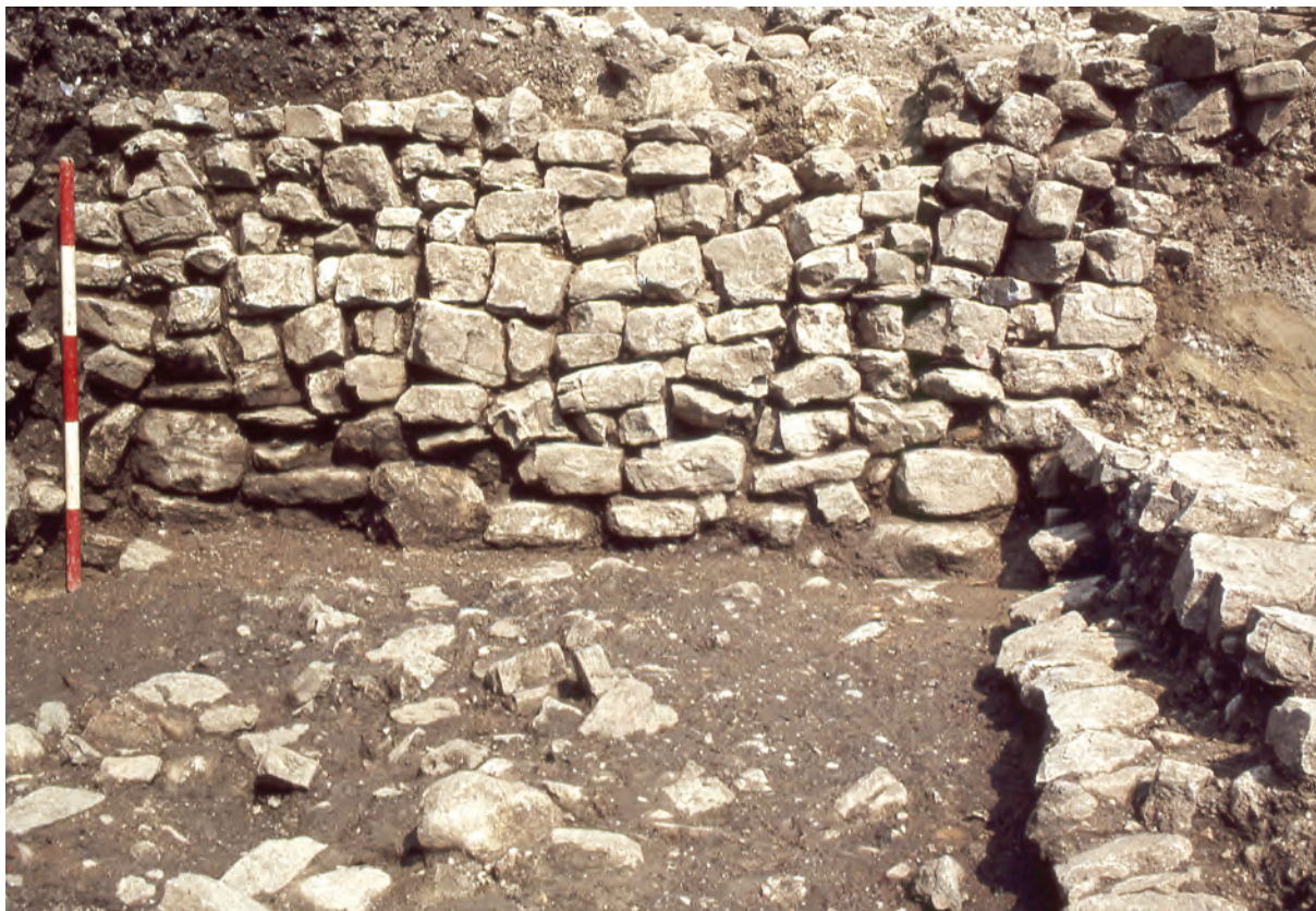
Sl. 199: Hiša 29. Gradbena faza 2, drenažni zid; pogled z juga.
