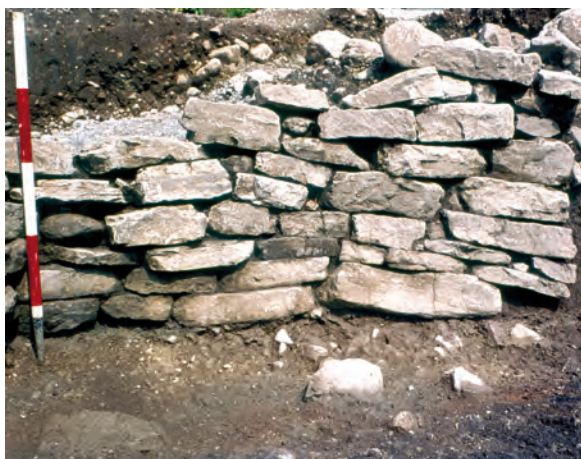
Sl. 82: Hiša 11. Jugozahodni drenažni zid. Fig. 82: House 11. Southwest drainage wall.
